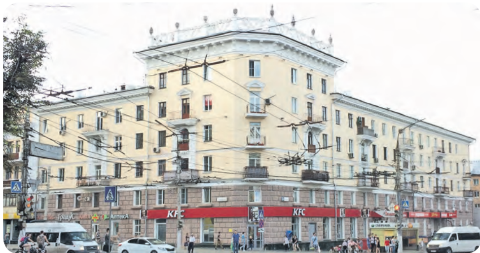
В доме №60 по проспекту Ленина компания «ОМД» провела ремонт кровли и подъездов.
