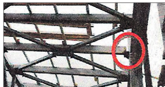
Там, где не хватило длины балки, приварили кусочек.
