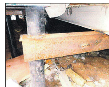
Модуль держится вот на такой сварной «подпорке».
