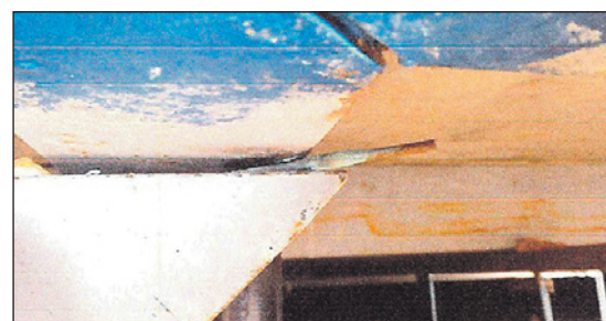
В качестве поддерживающего элемента использован... электрод!
