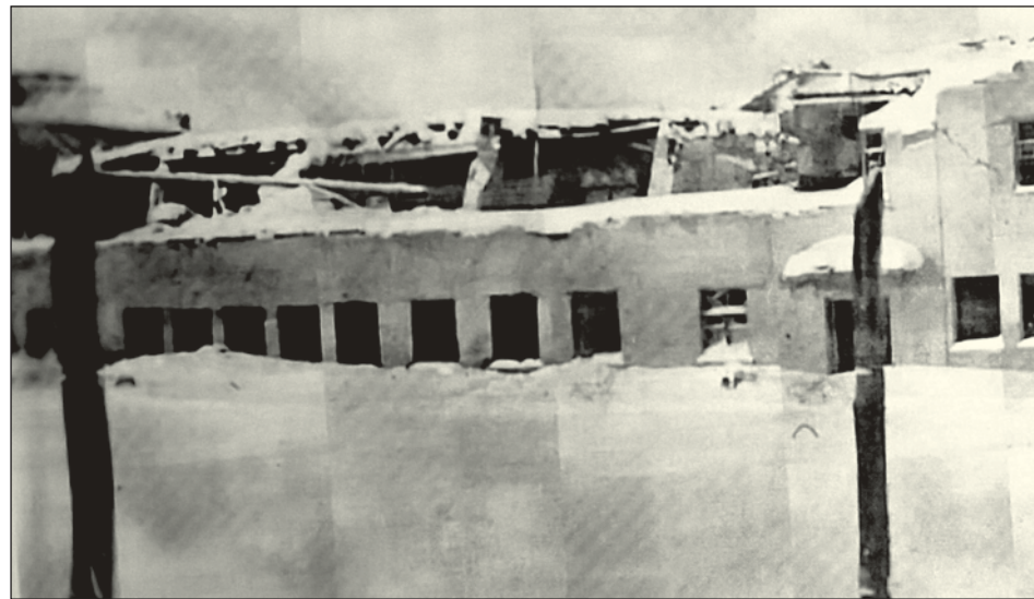
Дома в Туле, разрушенные во время бомбежки.
