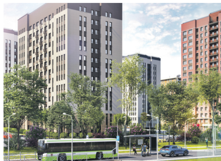
Строительство четырех домов уже завершено, еще два – в высокой степени готовности. Новоселье уже не за горами!
