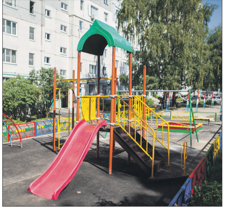
Тула, ул. М. Горького, 29-а. Теперь малыши будут играть на новенькой детской площадке – осталось только уложить покрытие.
