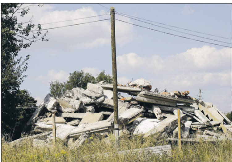
На месте дома, в котором прописаны люди, осталась груда строительного мусора.
