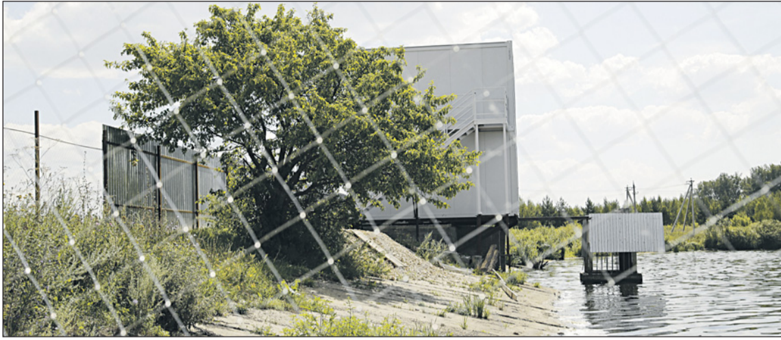
Территория с незаконной постройкой и шлюзом огорожена. Строение предприниматель должен снести не позднее 1 сентября 2018 года.
