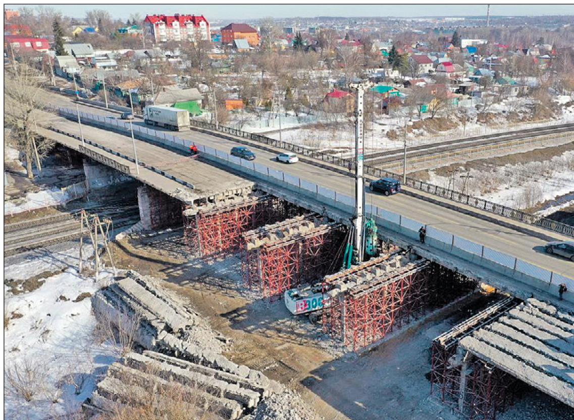
В Туле одновременно ремонтируют сразу три моста: Демидовский, Баташевский и Московский путепровод.
