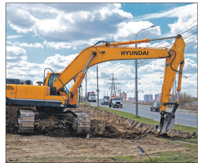
Строительство дороги на обводе началось 31 мая 2019 г.
