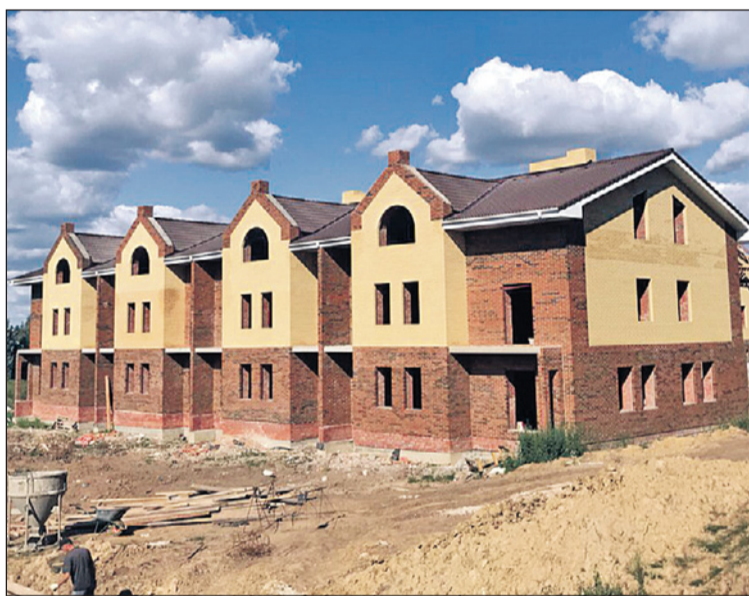
Сдача объекта назначена на второй квартал 2019 года. В трех домах из восьми строительство уже почти закончено.
