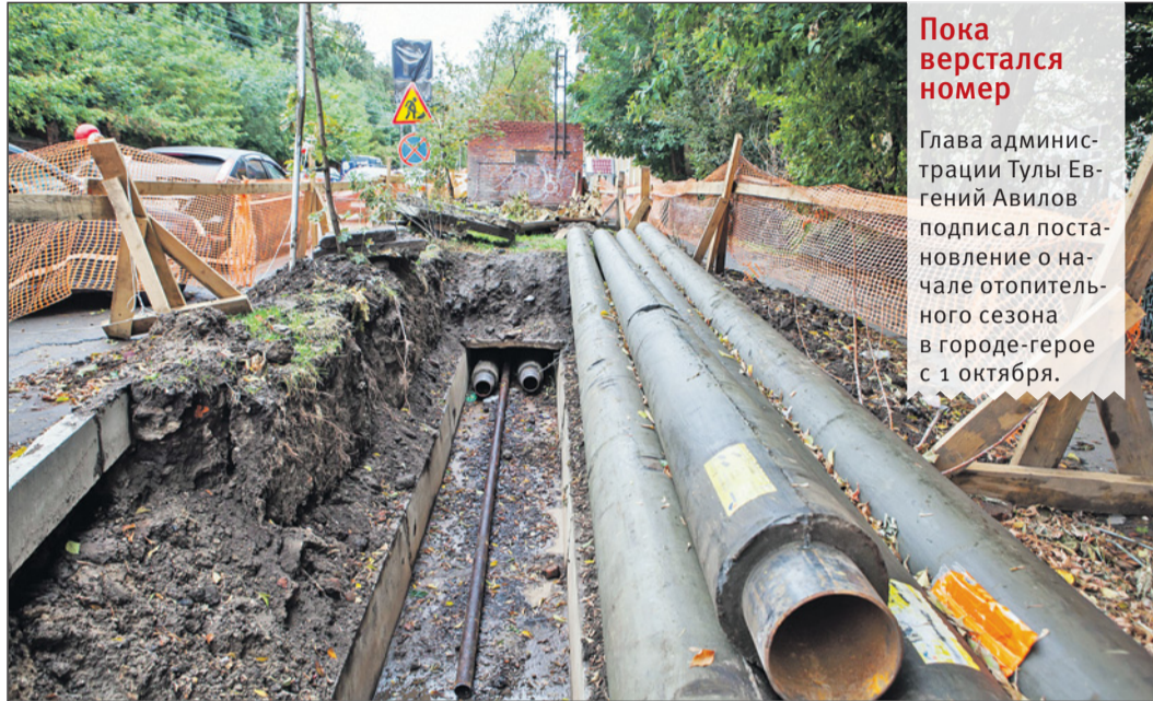
25 сентября 2018 года. Тула, ул. М. Тореза. Работы по замене коммуникаций при подготовке к зиме должны быть закончены к 1 октября.
