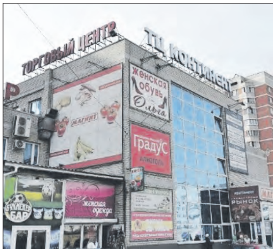
В фотоателье в ТЦ «Континент» эвакуационный выход заставлен горючими материалами.
