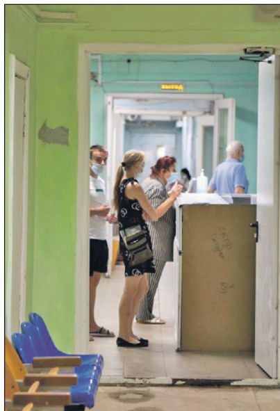
Медучреждение ремонтируют частями, чтобы не останавливать прием.
