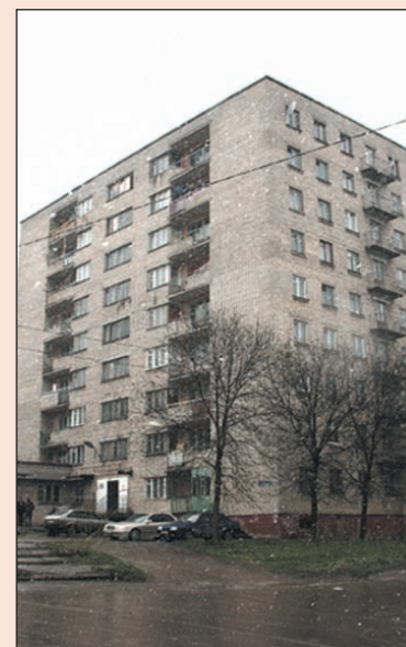
С виду 9-этажное общежитие на ул. Калинина, 4/131 находится в хорошем состоянии, вот только пожарная безопасность в нем отсутствует.
