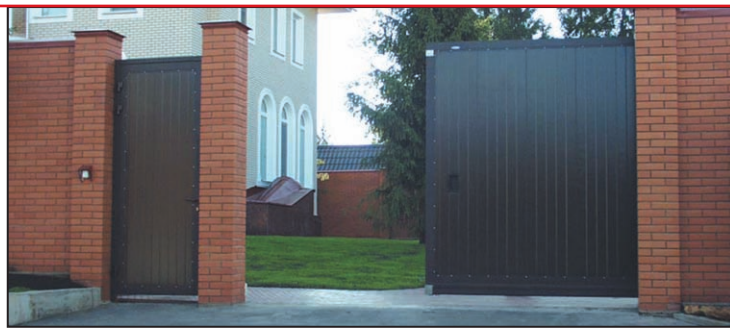
Откатные консольные уличные ворота прекрасно дополняют архитектуру вашего дома и обеспечивают высокий уровень защиты от взлома.
