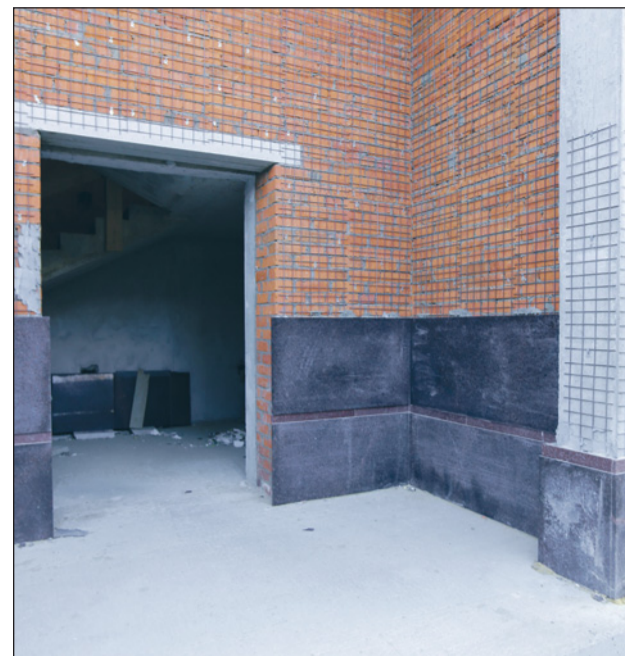
Первый этаж по периметру облицован северным гранитом. Этот натуральный материал роскошно выглядит и отличается потрясающей прочностью и долговечностью.
