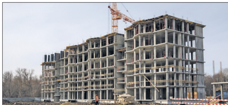
В одном из домов жилого комплекса завершается возведение монолитного каркаса, скоро начнутся работы по кирпичной кладке стен.
