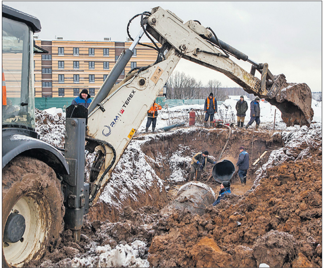
15.01.2019. Поселок Молодежный Пролетарского округа Тулы. «Тулагорводоканал» ведет ремонтные работы на водоводе диаметром 900 мм.
