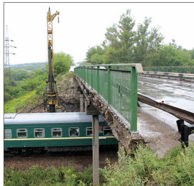
Мост у дер. Китаевка в районе «Метро» отремонтируют частями.
