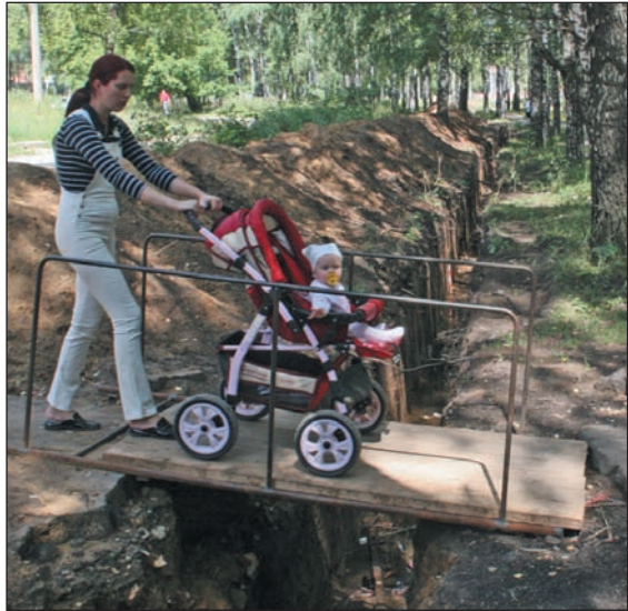
Теперь в любимом уголке жителей Криволучья красуется полтораметровая траншея. 1 августа 2007 г.
