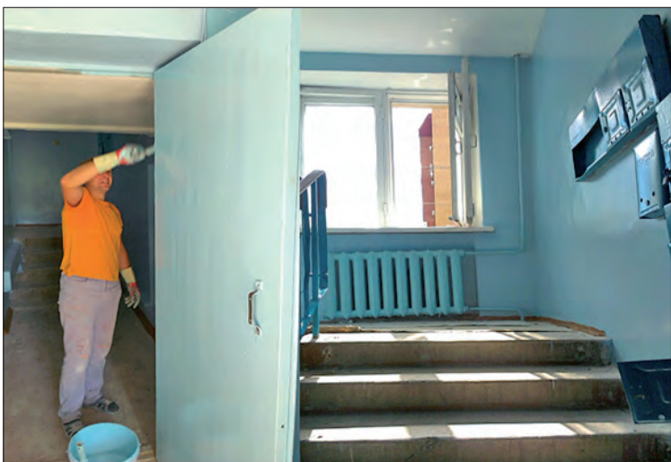
Тула, ул. Вересаева, 9. Завершается ремонт подъезда.
