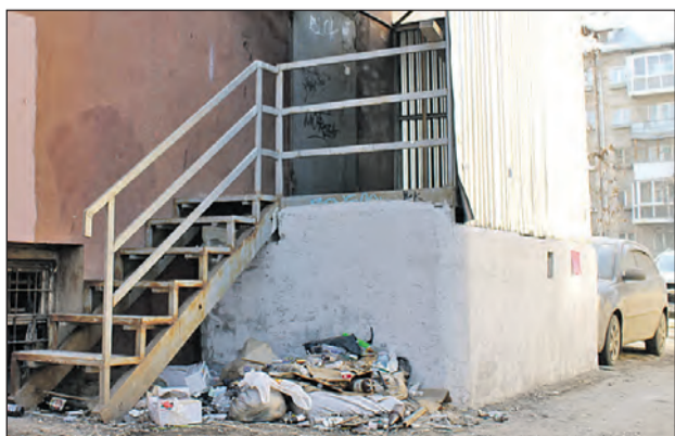
Угол дома по ул. Дм. Ульянова, 17 – зона ответственности управляющей компании этого дома.
