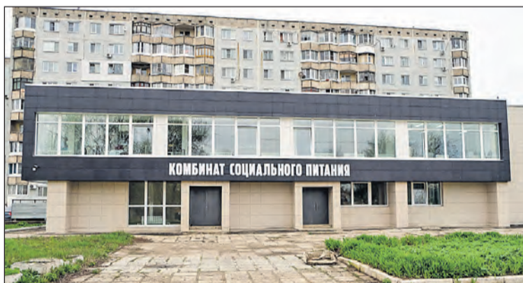
Тула, ул. Луначарского, 67. ТД «СПП» реконструировал здание для размещения в нём комбината питания.
