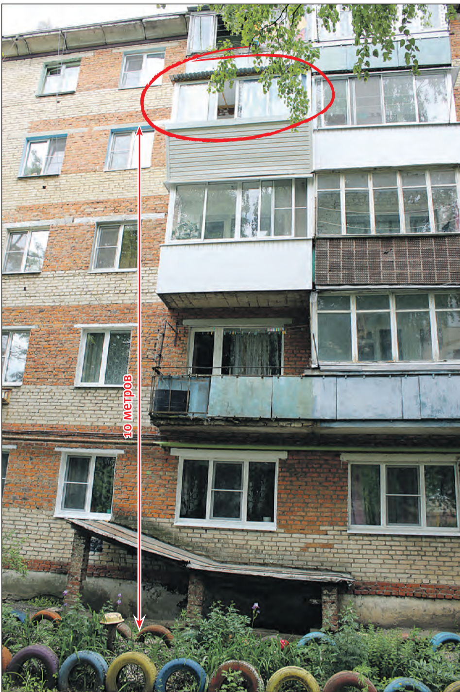
Киреевск. На фото балкон, из окна которого выпал ребёнок. Мальчик пролетел около десяти метров!
