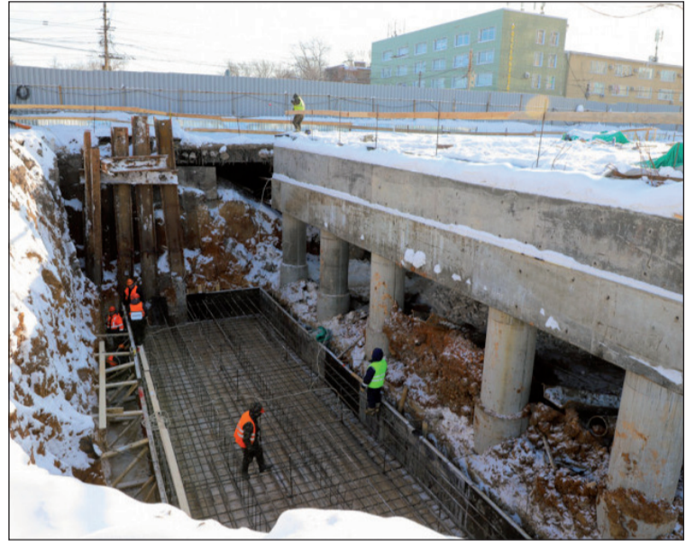
Реконструкция Орловского путепровода проводится в два этапа. Окончание работ – осенью 2026 года.
