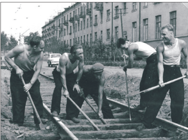
Укладка рельсов на ул. Metallургов.
