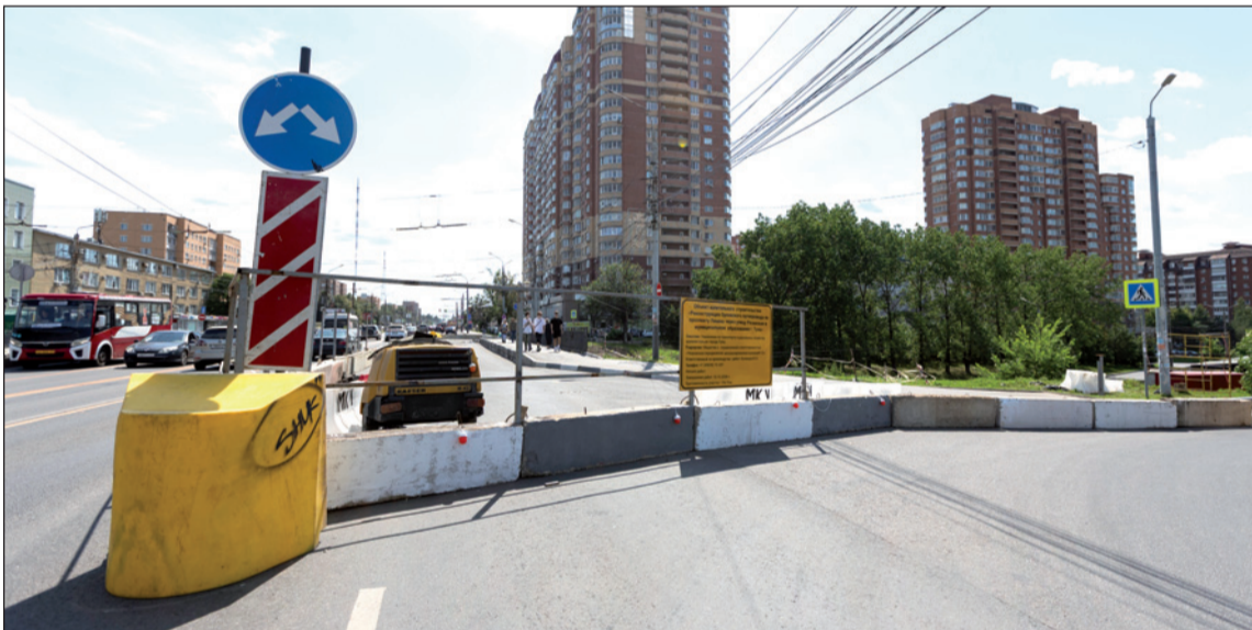
Калужское шоссе в первый день ремонта стояло в пробке на въезд и выезд из города. После перенастройки светофоров, регулирующих реверсивное движение в районе проведения работ, движение наладилось.
