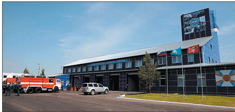
Тула, Новомедвенский пр., 14. Новая «пожарка» напоминает современный торгово-развлекательный центр.
