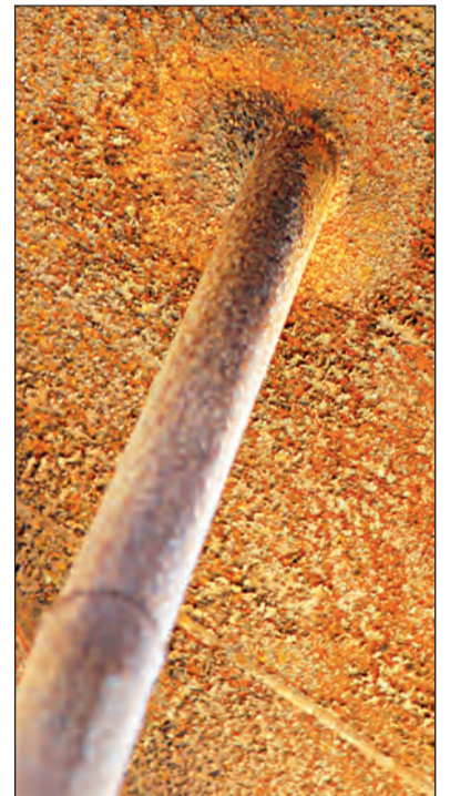
Внутри водонапорной башни почти за 50 лет её существования проржавело абсолютно всё!
