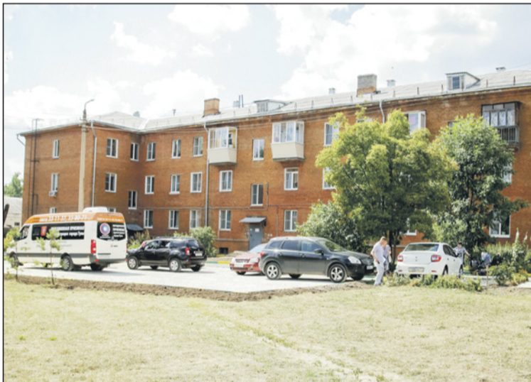
После благоустройства во дворе дома №15 по ул. Волкова появилась дополнительная парковка на 22 машино-места.
