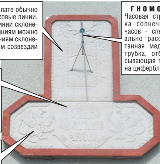
**ГНОМОН.** Часовая стрелка солнечных часов - специально рассчитанная медная трубка, отбрасывающая тень на циферблат.
