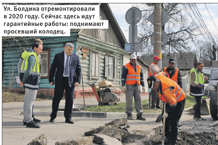
Работы на ул. Кутузова в активной фазе: ремонт начали 10 апреля.
