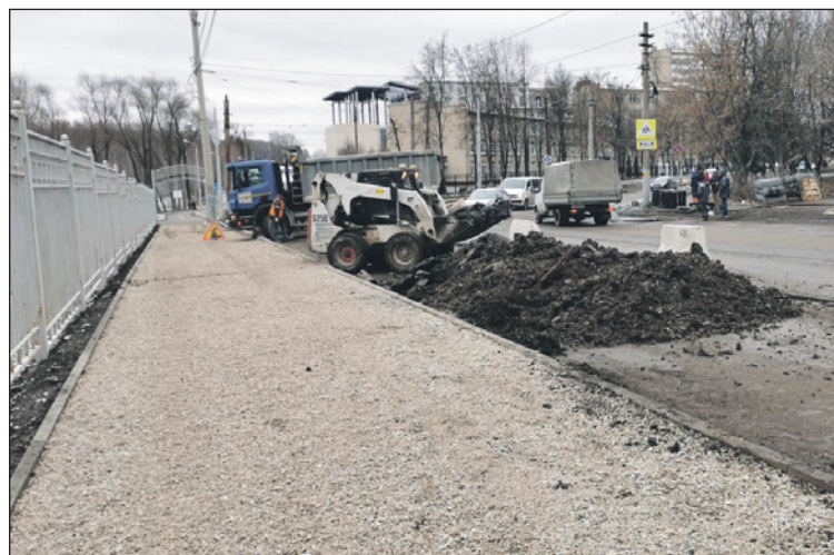
16 ноября 2023 года. Тула, ул. Оружейная. Готовность объекта 90%.
