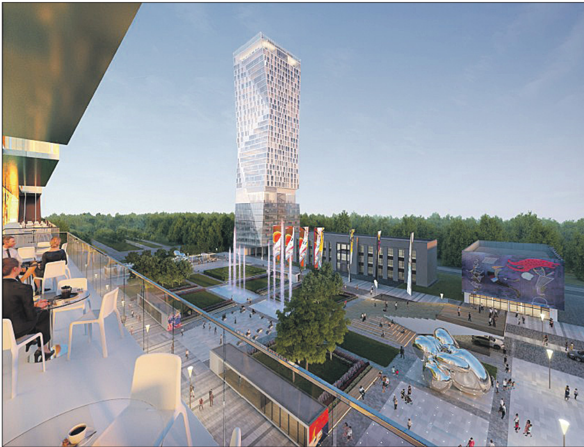
Рядом со зданием Тульского областного художественного музея собираются построить фондохранилище с интерактивной стеной и 36-этажный офисно-апартаментный комплекс.
