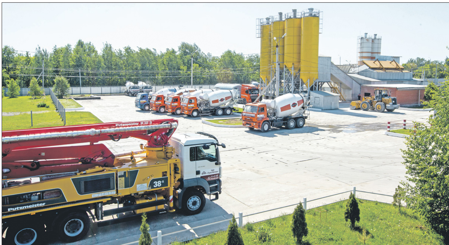
Два бетоносмесительных комплекса, крупный парк собственного автотранспорта и запасы материалов позволяют заводу «Тула-Бетон» выпускать продукцию 24 часа в сутки круглый год.
