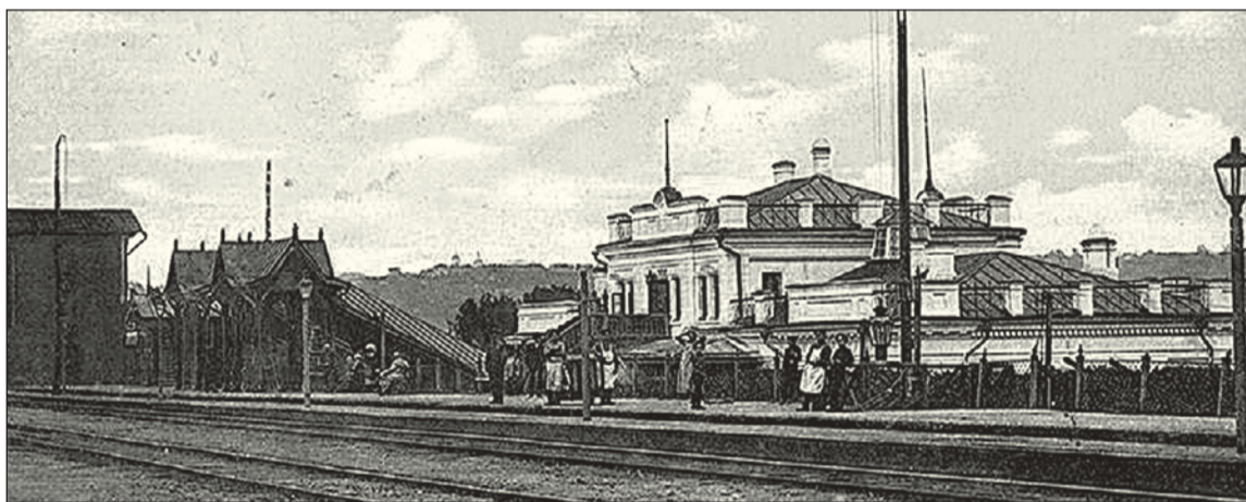
Станция Алексинской железной дороги. Субботним вечером прибывали поезда с дачными мужьями. Начало XX века.
