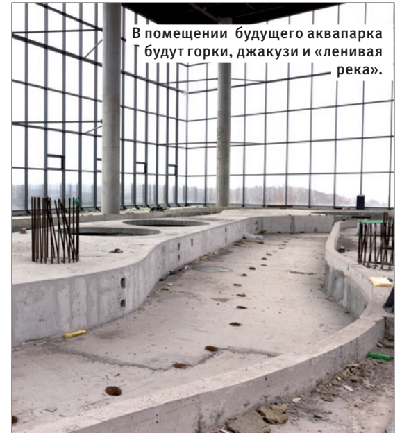
Здание на ул. Фридриха Энгельса строят уже несколько лет.
