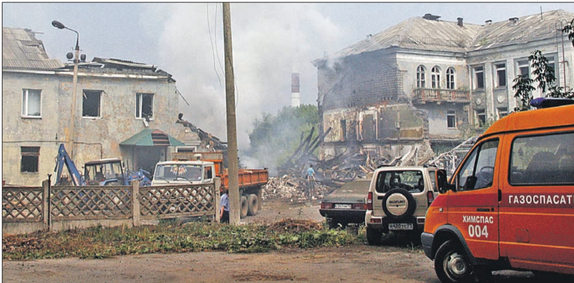
24 июля, около 12.00. Новомосковск, ул. Транспортная, 10. Взрыв был такой силы, что разворотил добрую половину здания химической лаборатории ООО «Реаген».
