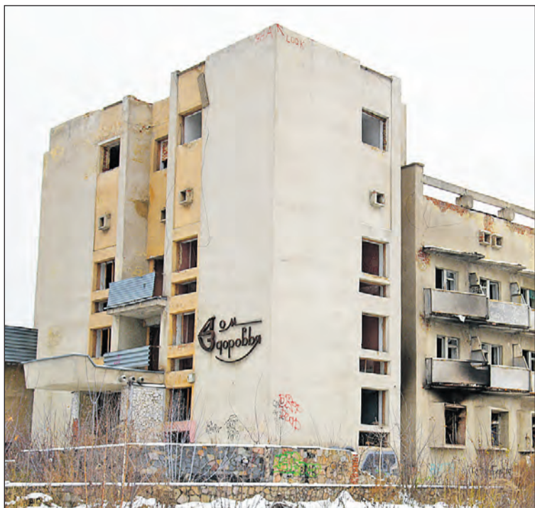
Заброшенный профилакторий на Веневском шоссе притягивает подростков, бомжей и любителей острых ощущений.
