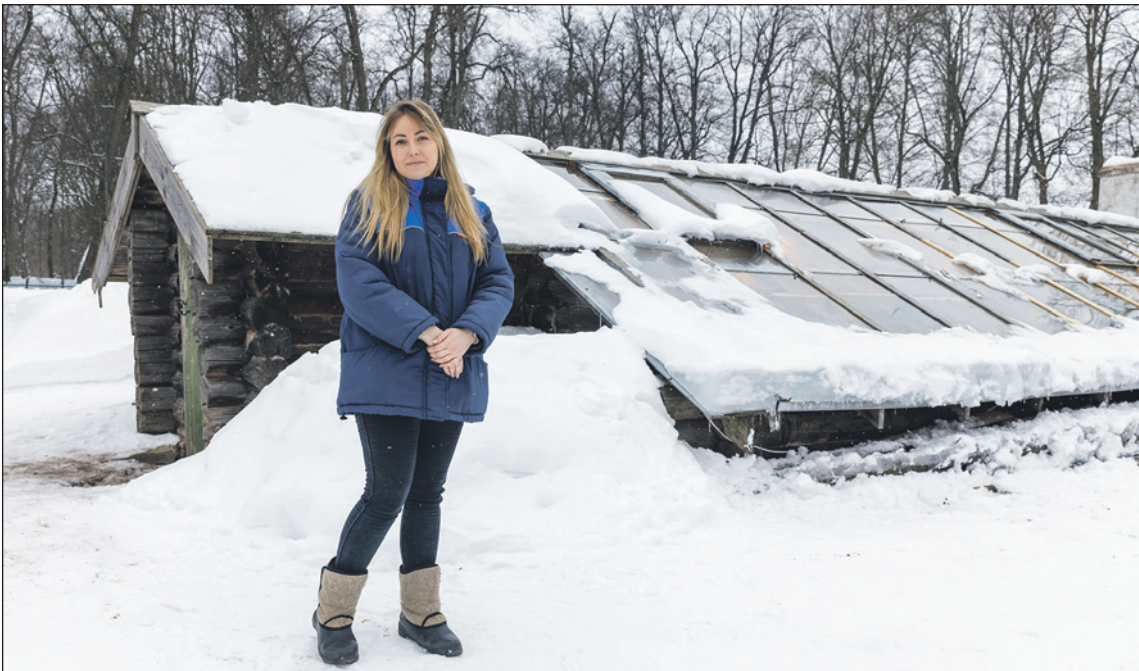
У теплицы полутораскатная остекленная крыша – снег быстро скатывается, и в теплице светло. Внутри же теплица разделена перегородкой, просторная и высокая, хотя внешне кажется небольшой. На фото Анна Кузнецова.
