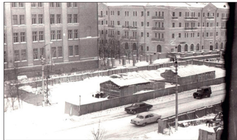
Вот так выглядело строительство первой подземки на проспекте Ленина.
