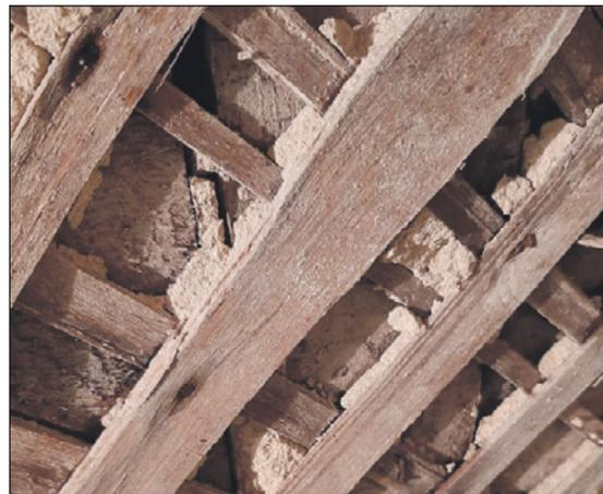
Перекрытия в доме деревянные. Они не выдерживают такой бетонной нагрузки.
