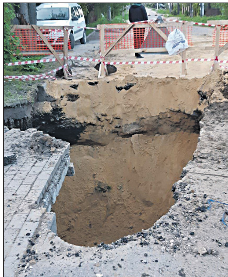
Когда трубу отремонтировали, яму глубиной метров в 5-6 начали засыпать песком.
