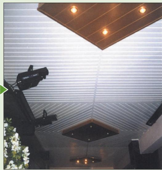
**ОБШИВАЕМ ГИПСОКАРТОНОМ.** Лучше выбирать толщиной 10 мм. Если форма конструкции округлая, то гипсокартон нужно слегка намочить — тогда он легко гнется. Гипсокартон крепим специальными саморезами. Швы и стыки проклеиваем «серпянкой» — специальной клейкой лентой. Теперь — грунтовка, шпаклевка и покраска либо на-
