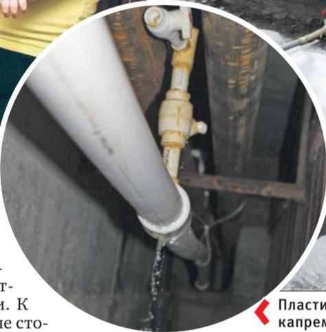
Пластиковые трубы, установленные в ходе капремонта, уже вовсю текут!
