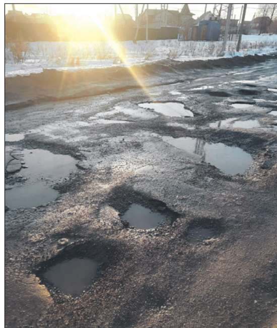
Ямы в пос. Плеханово создают опасную ситуацию на дороге, и вынуждают жителей тратить на ремонт.
