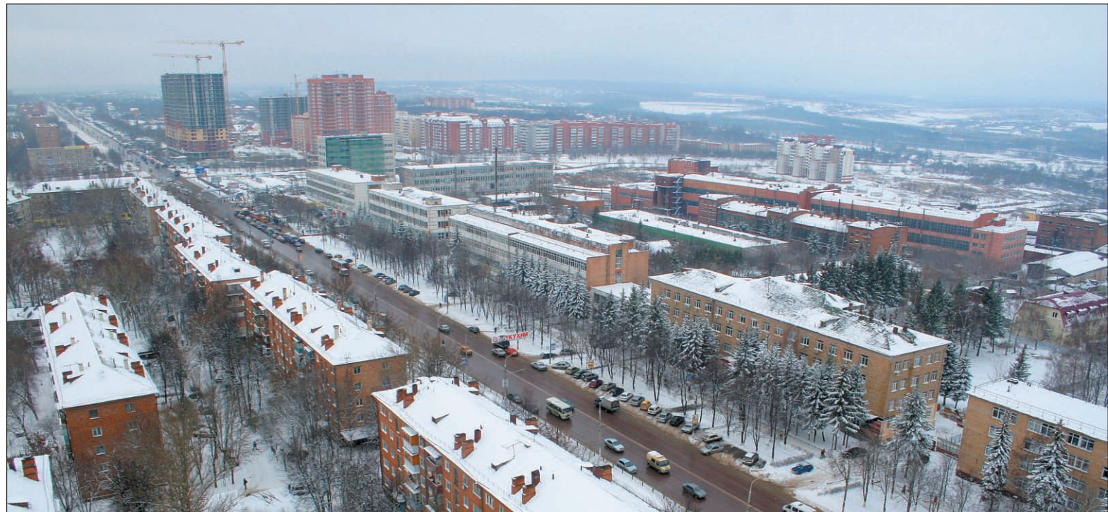
Кроме возможности распоряжаться квартплатой члены товариществ собственников жилья могут получить средства на капитальный ремонт домов.
