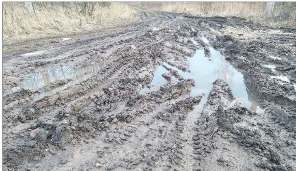
В 2024 году половину дороги отсыпали щебнем. Но потраченные на это бюджетные деньги быстро утонули в грязи – уже в начале осенней распутицы от щебня не осталось и следа.
