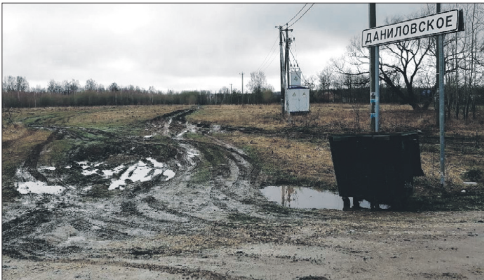
Так дорога выглядела весной 2022 года. Она не выдержала нагрузки мусоровоза и превратилась в месиво под его весом.
