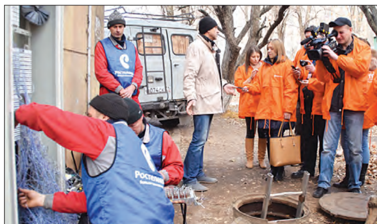
Блогеры побывали и на ремонте сети связи.
