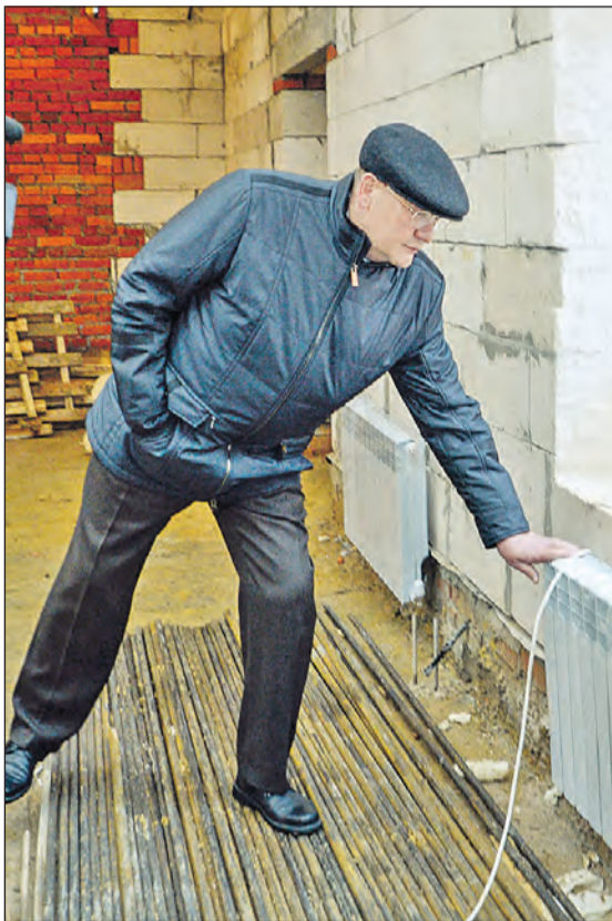
Сергей Харитонов проинспектировал ход строительства Дома культуры в Пахомово.
