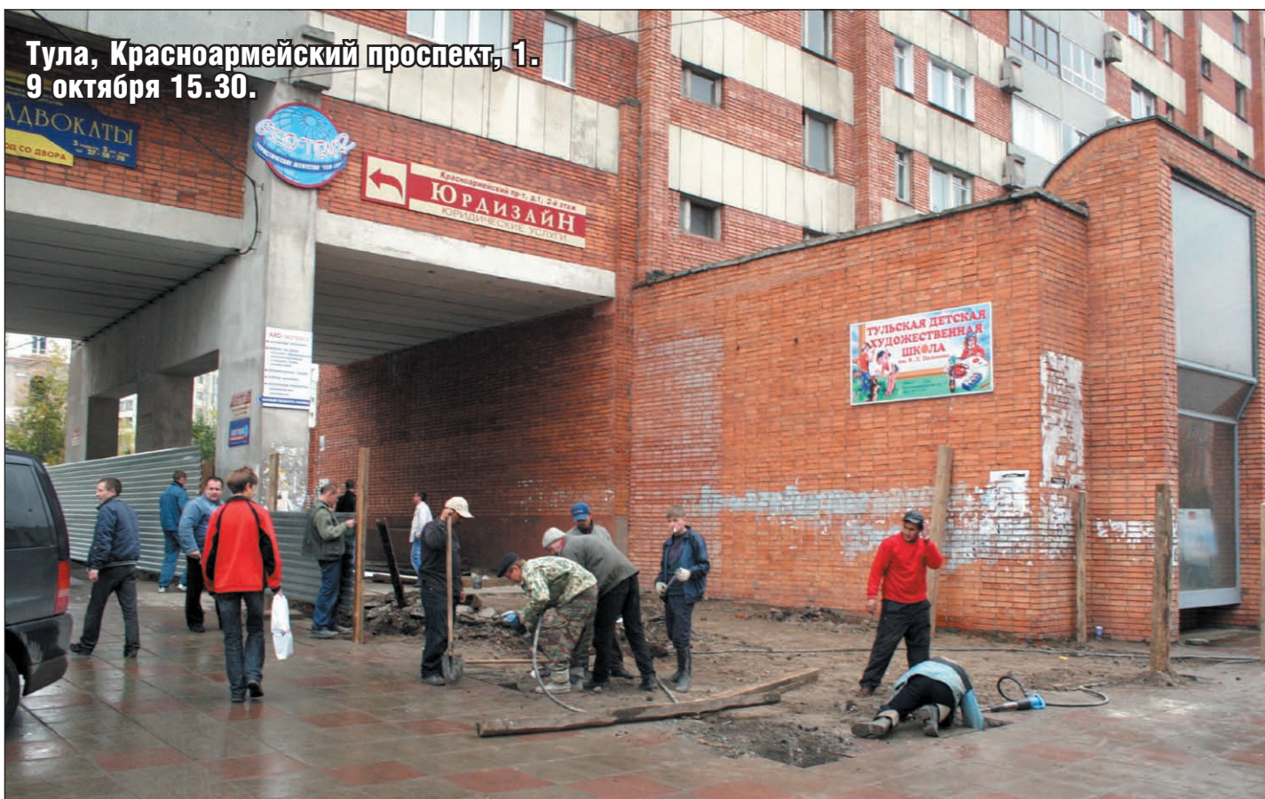
Строители отгородили территорию и начали строить магазин в арке дома.
