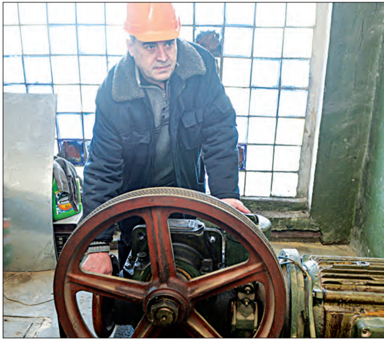
Игорь Кузьмин, бригадир электромехаников: «У троса лифта 12-кратный запас прочности. Не может лифт просто так упасть!»
