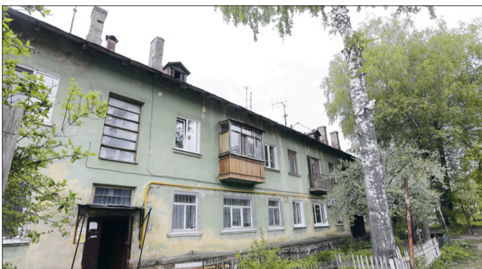
Тула, ул. Маяковского, 1-а. Жильцы этого дома терпят жуткие неудобства с февраля.
