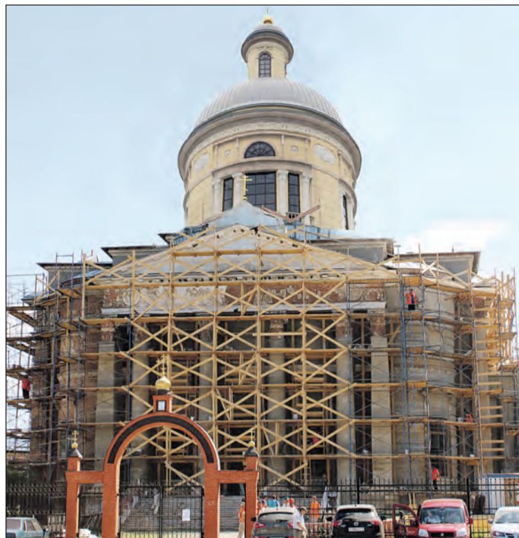
Леса со Свято-Никольского собора снимут уже совсем скоро. В сентябре 2015 года реконструкция полностью завершится.
