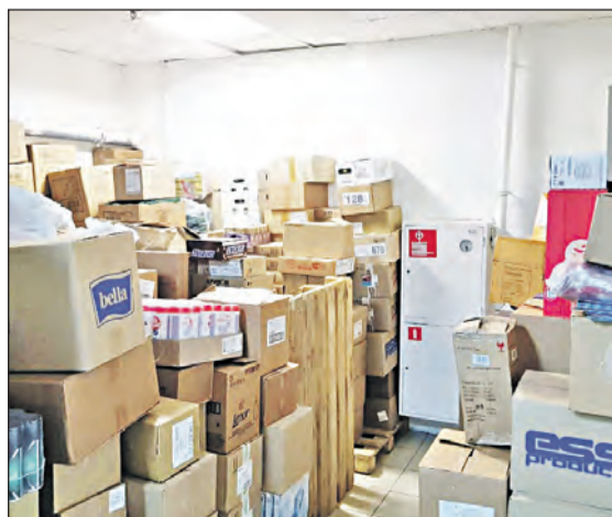
ТЦ «Континент». Вместо пути к спасению при ЧС здесь – склад горючих материалов.
