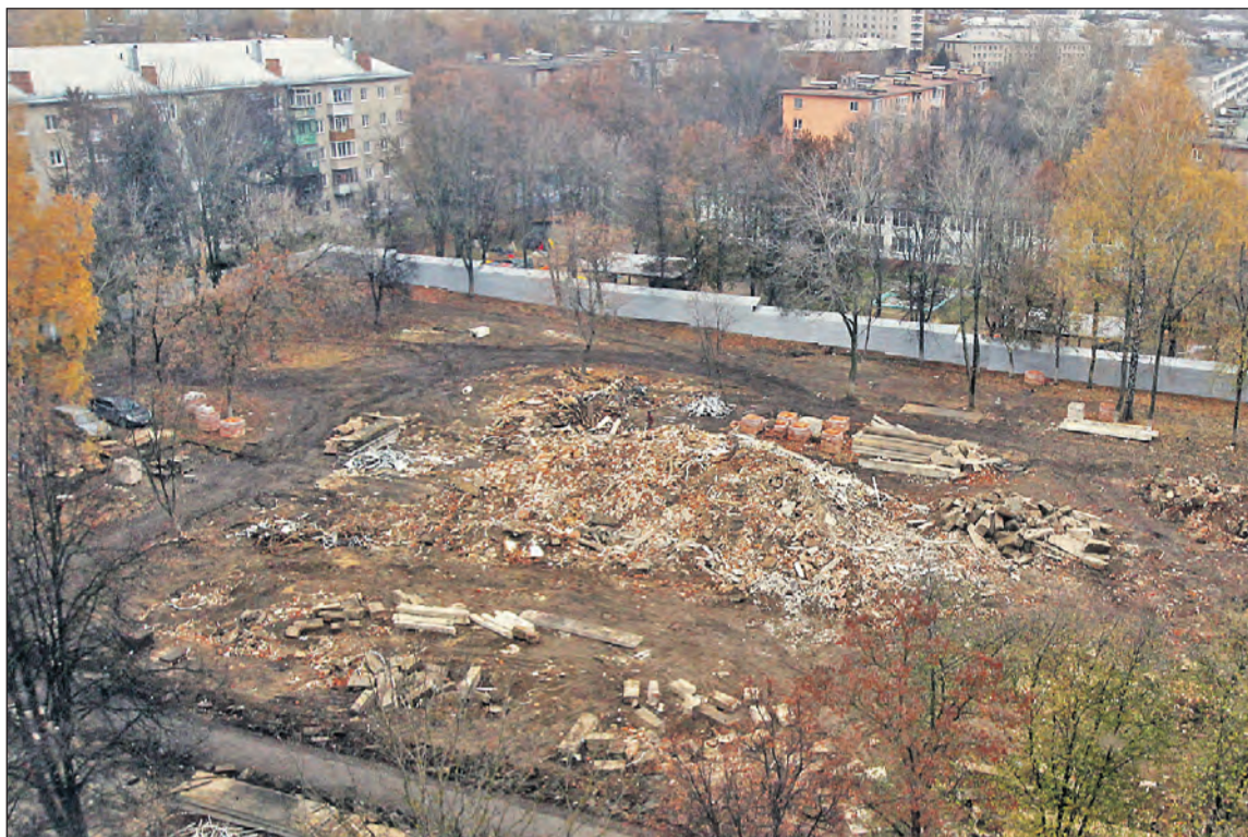
Работы по сносу здания по ул. Вознесенского, 5, не дающие покоя жителям, практически завершены.
