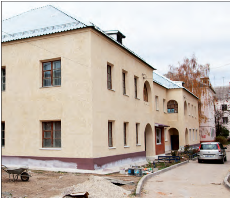
К 30 октября в доме №21 по ул. Ленина (г. Алексин) завершат все работы. На его капремонт потратили около 4 млн рублей.
