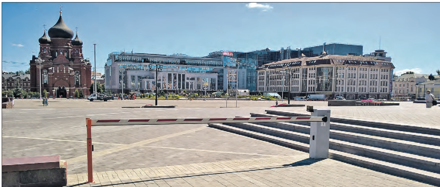
У парковки «белого дома» большая проходимость, поэтому здесь установлены гидравлические шлагбаумы с высокой ресурсоспособностью.
