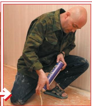
Отверстие забивается монтажной пеной для надежности.
