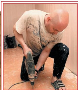
Саморез длиной 150 мм, сверло диаметром 6 мм.
