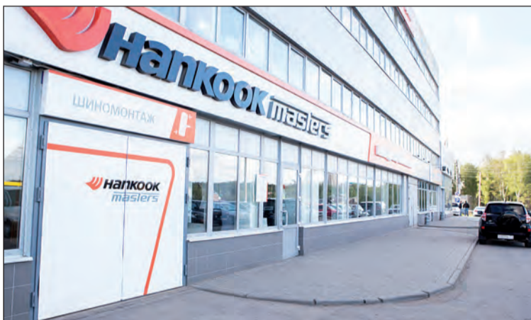
Шинный центр и шиномонтаж – в одном здании на Рязанской, 38.
